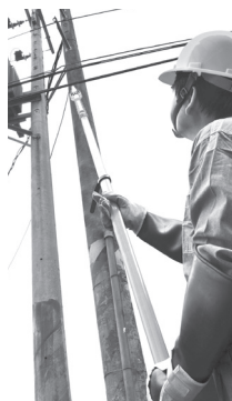
Fig. 3: Detección de voltaje en líneas aéreas
